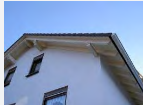
Ortgang und Traufe mit erkennbarer Sparrenlage
